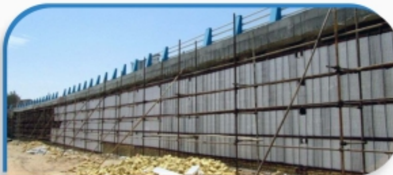
اجرای دیوار حائل تقاطع غیر همسطح
